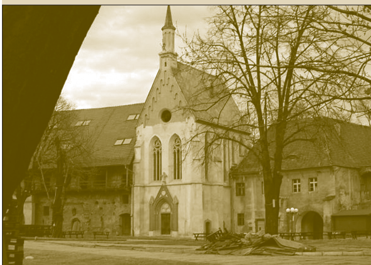
Kaplica zamkowa, budynek bramny i część budynku mieszkalnego.
