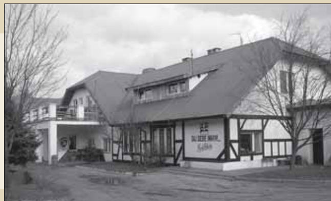
Budynek Monaru od strony głównego wejścia.
